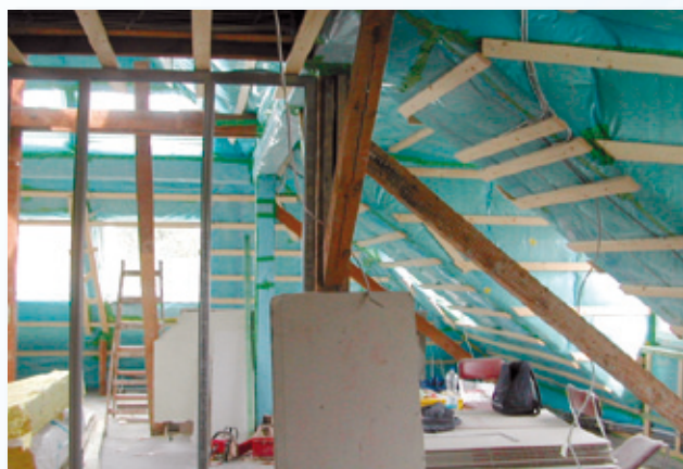
La mesure BlowerDoor pour la démarche qualité pendant la construction
