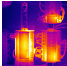
Contrôle électrique par thermographie
